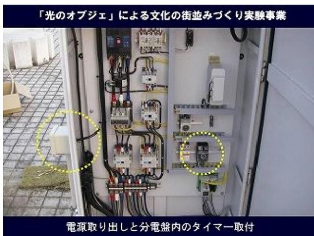
左側の方から電源を取り出すような形にしています。分電盤から先ほどの場所までケーブルをつなげなければならないのですが、仮設だと耐久性の問題だけでなく引っ掛かるなどの危険性もありますので、せっかくお金をかけるのであれば埋設配管してしまおうということで埋設しました。先端のケーブルの取り出し口はイルミネーションの電源を使わない時期は収納をしておけるようにボックスを埋め込んでいます。
